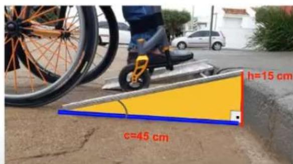
Nós sabemos a altura e o comprimento da base na figura. A taxa de inclinação da rampa atende aos parâmetros da norma?
