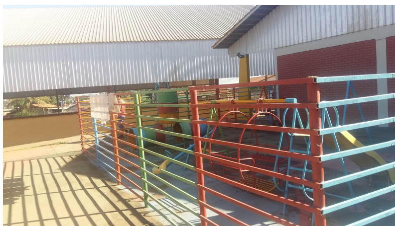
Figura 2: Parque infantil da escola, ao fundo a quadra interditada
