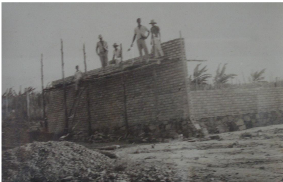
Figura 1 - Construção do prédio escolar - bloco 01 - Acervo CNEC - Mairi
