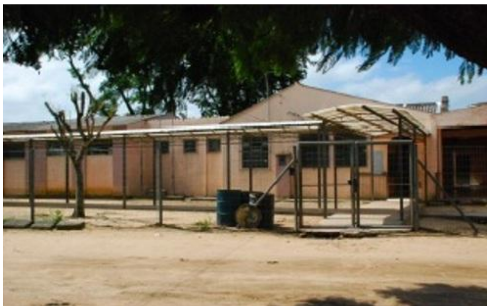
Figura 1: Fachada da escola
