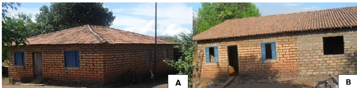
Imagem 04 – Ampliação da casa da família de Ruimar. Ruimar Antônio de Farias, 2011.
