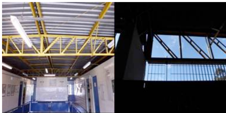
Fig.1 e 2 – Estrutura do telhado
